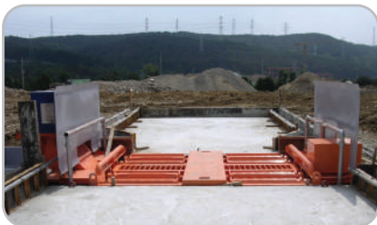
⑬진출입로 콘크리트 타설
