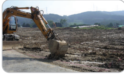
②터파기 작업 실시
