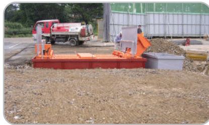
⑪되메우기 및 진출입로 다짐 작업
