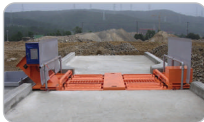
⑭이동식 PIT공사 기초공사 완료
