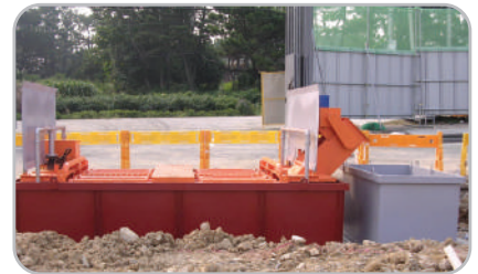
⑨세륜기 설치 작업
