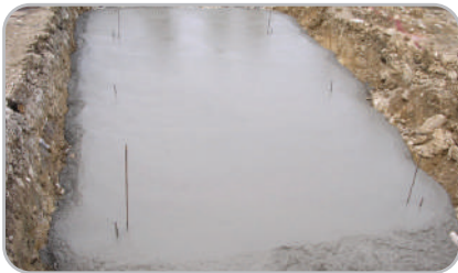
⑦바닥콘크리트 타설 완료(5,200×2,700×T:200)
