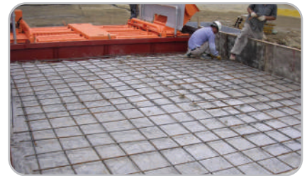
⑫진출입로 철근배근 작업(규격:철근D13@200)
