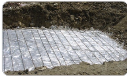
⑤비닐포장 및 버림콘크리트 작업
